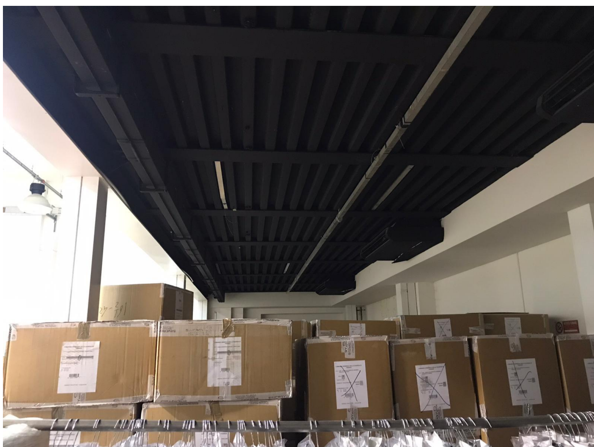
Figura 86 – vista interna al doppio volume dell'edificio C2 – solaio in lamiera grecata (da demolire)
